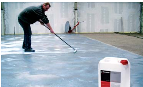
5 Nach Erreichen der »Begehbarkeit« wird ein Verdunstungsschutz aufgetragen (z.B. Meboplast®, im Verhältnis 1:2 mit Wasser verdünnt)
