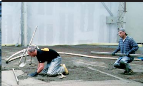
2 Aufziehen des Estrichs unter Einhaltung der vorgegebenen Höhenlage
