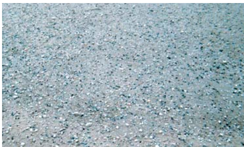
3 Estrichoberfläche mit Hartstoffeinstreuung (Hartstoffe nach DIN 1100)
