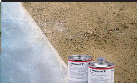
6 Tagesansatzfugen sollten vor der Bodenbelagsverlegung mit einem Reaktionsharzsystem (z.B. Thixopont, F) »kraftschlüssig« verschlossen werden
