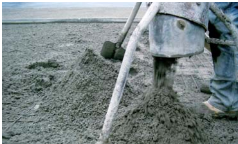
1 Einbau eines Zementestrichs als Industrieestrich
