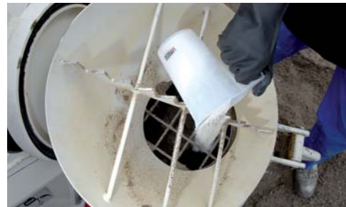
1 Anhyplast® wird mit einem Teil der Gesteinskörnung vorgemischt.
