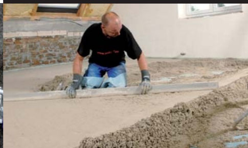
4 ... und der Estrich wie gewohnt verlegt – mit deutlich weniger Wasser.
