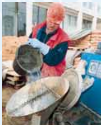
Pro Tag werden auf einer Baustelle 30 bis 35 Mörtelmischungen hergestellt.
